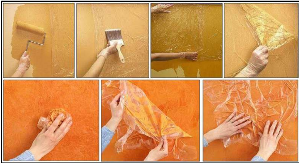
شكل رقم (3-34) طريقة التعتيق في إظهار الرخام
