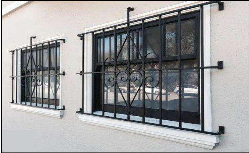
شكل رقم (3-43) استخدام الحديد في غطاء الشبابيك
