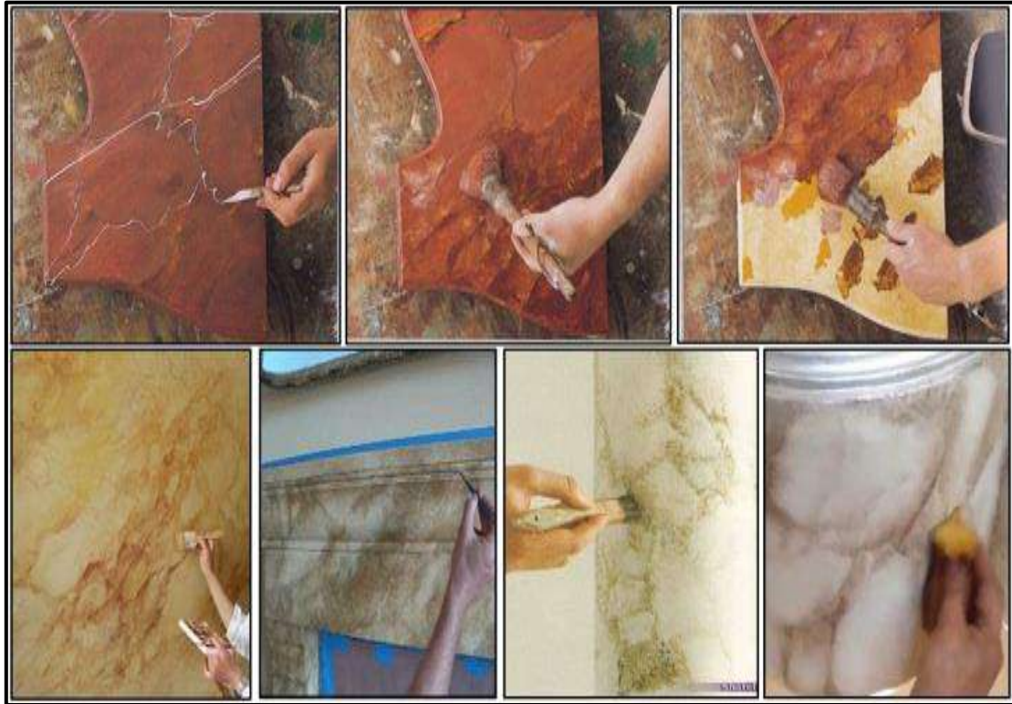
شكل رقم (30-3) يظهر طريقة الرسم في إظهار الرخام
