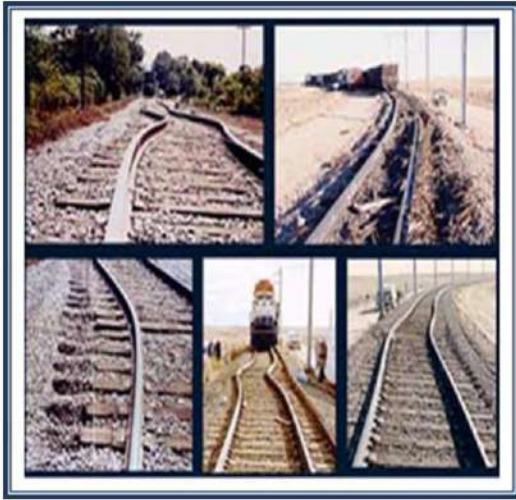
شكل 5-7 انحناء خطوط السكك الحديدية بسبب التمدد الحراري.
